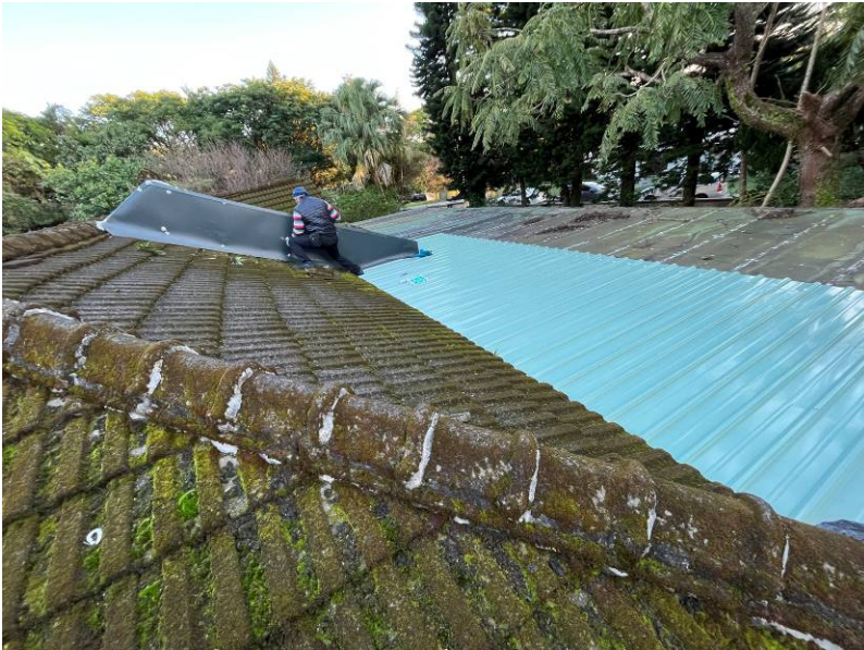
圖二十三、草山猛禽中心屋頂防水鐵皮鋪設。
